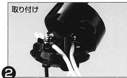
母線電線を電線出入り口に束ねた後、片方のツメ部をはめ込み、**その後**斜めの状態からワンタッチキャップをかぶせる。
